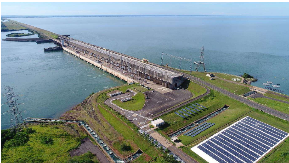
Figura 1 – Vista geral da barragem da UHE Porto Primavera
